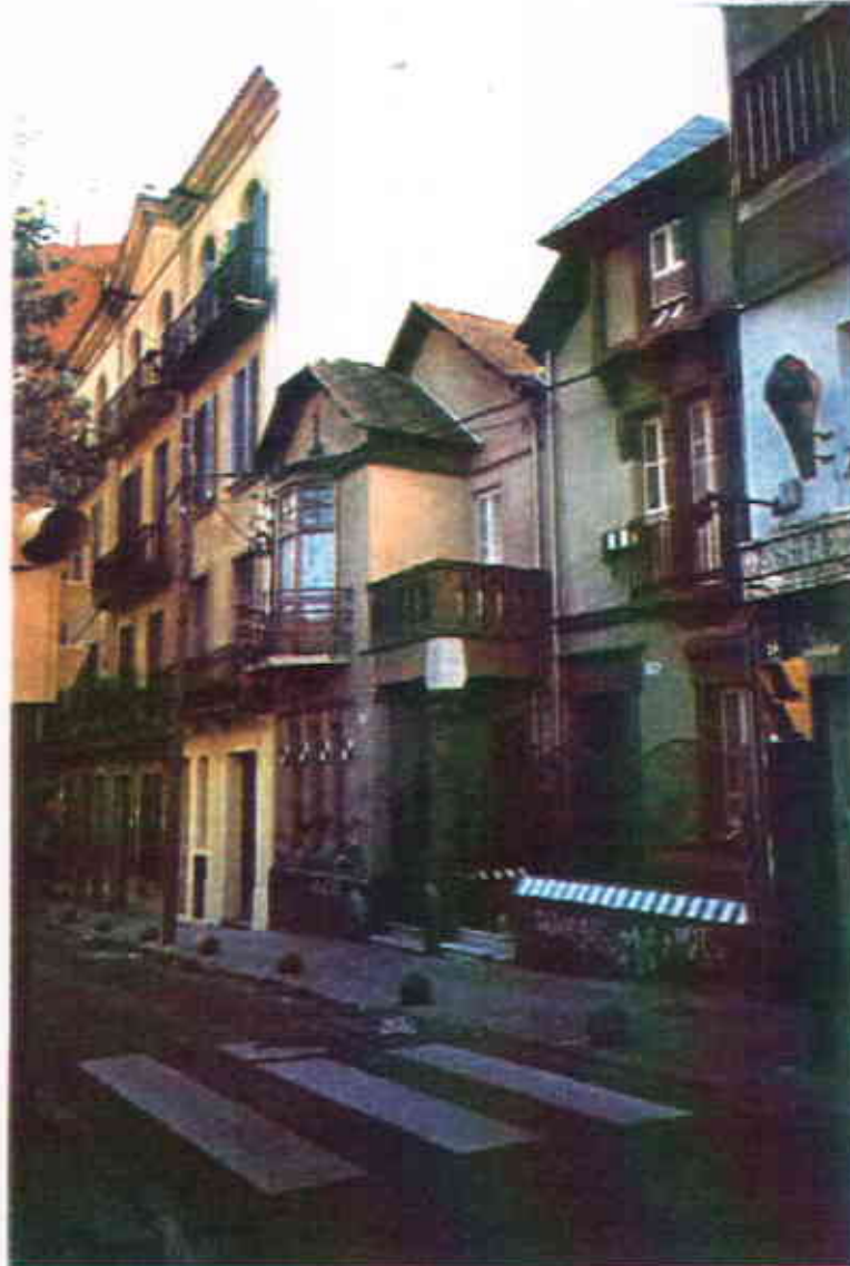
Vista general de la façana ( Novembre 1994 )
